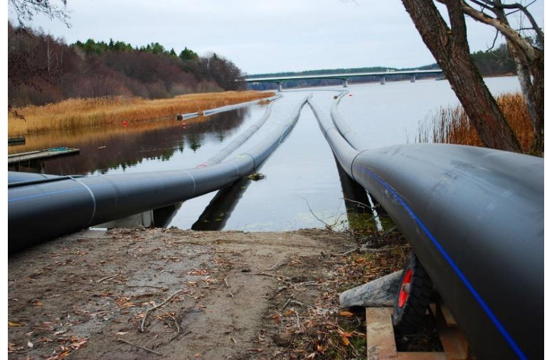
Effektiv installation av långa rörlängder. Bild med tillstånd från Wavin, copyright Wavin
