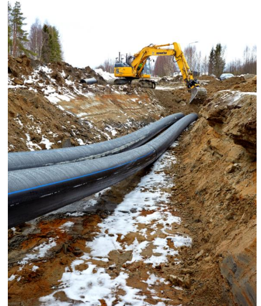
PE100-RC installation i Sverige – en vanlig syn Bild med tillstånd från Extena. Copyright Extena
