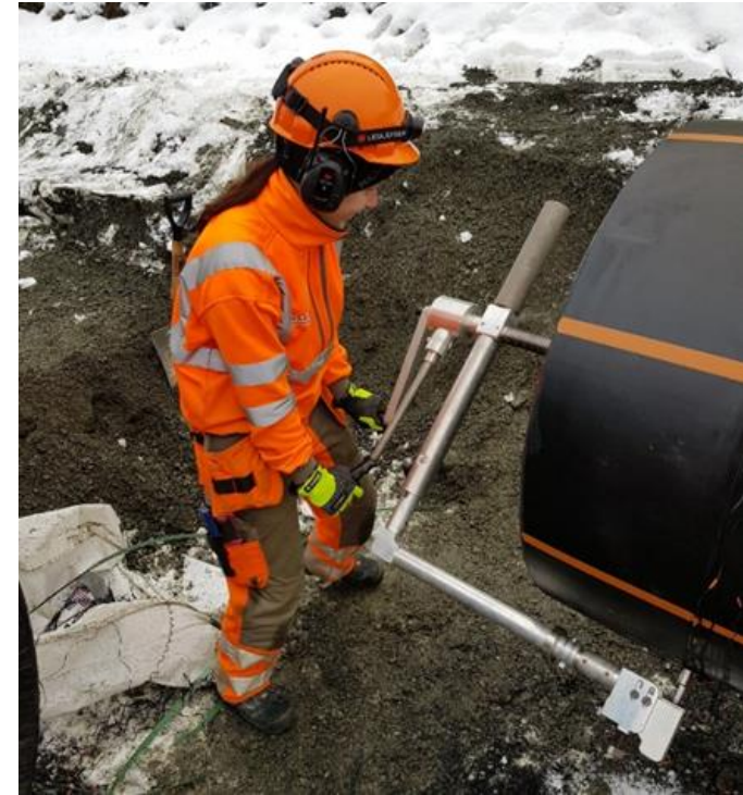
Exempel på professionellt utförd rörskrapning före elsvetsning, 1000mm rör. Bild med tillstånd från Hallingplast. Copyright Hallingplast
