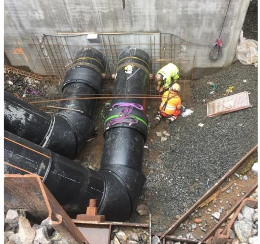
PE100, rördiameter 1000mm, installation genom, stumsvets och elektrosvets. Bild med tillstånd från Hallingplast, Copyright Hallingplast
